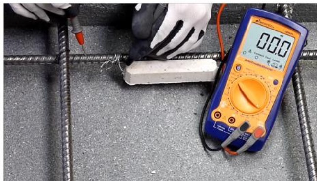
Fig. 5 Instalação e Teste do Anodo
