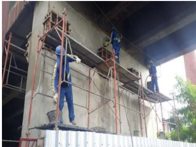
e) Concretagem dos pilares.
