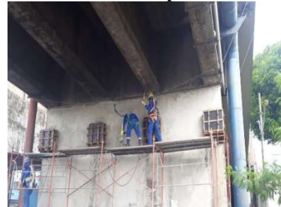
f) Adensamento do concreto nos consoles.
