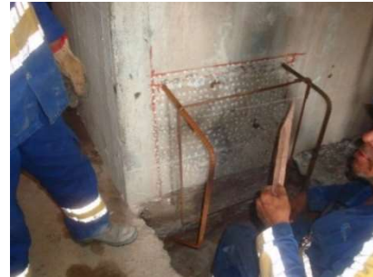
b) Montagem da armadura do console.
