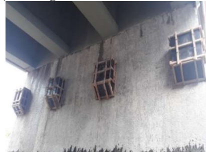
d) Consoles com as formas posicionados no pilar.
