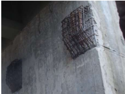
c) Armadura final do console.
