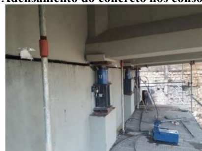
h) Cilindros hidráulicos apoiados nos consoles.
