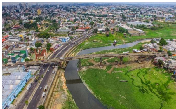
Figura 7 - Vista panorâmica da ponte. Fonte: PROCEC, 2019.
