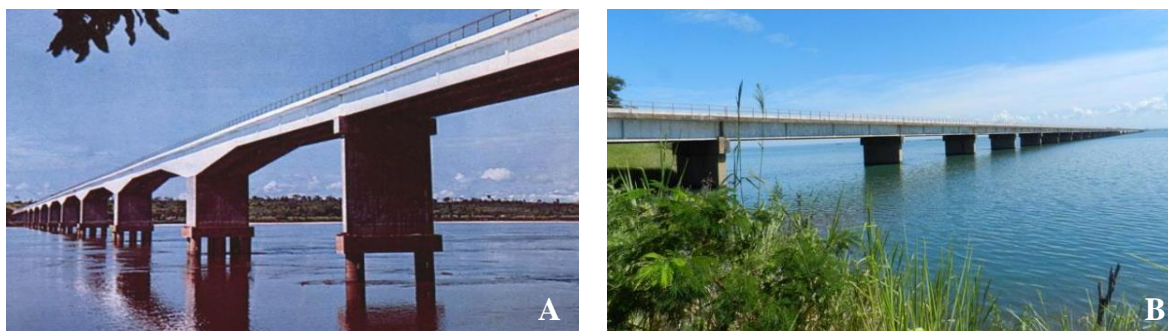
Figura 2 – Mudança no nível de água da ponte após construção de barragem a jusante. A – Nível antes da construção da barragem. B – Nível após a construção da barragem. Fonte: Eduardo Thomaz – Ponte sobre o Rio Paraná (1965).
