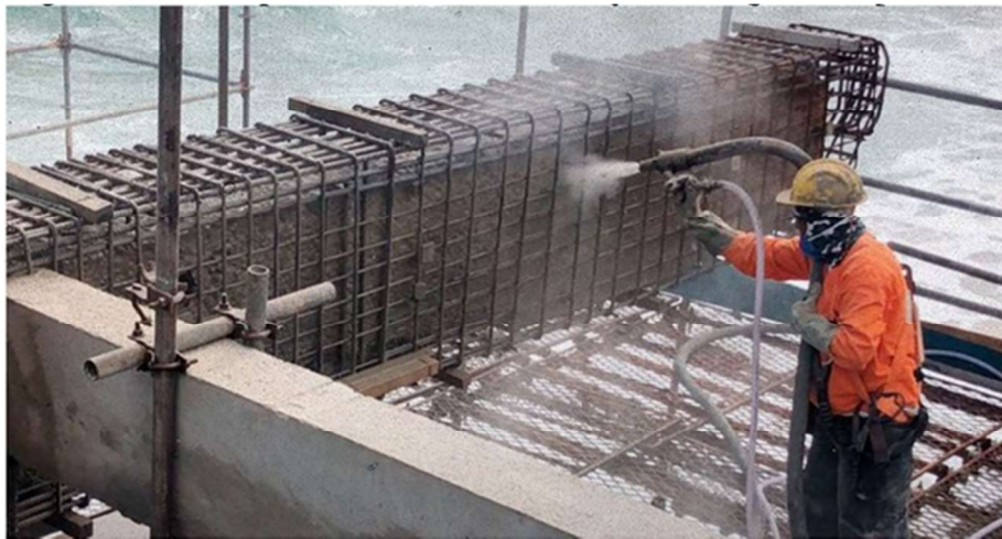
Figura 9 – Limpeza do substrato com jato de água sob pressão.
