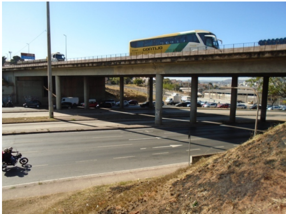
Figura 2 - Vista geral dos viadutos da Av. Antônio Carlos.
