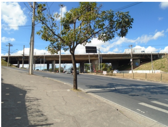
Figura 4 - Vista geral dos viadutos da Av. D. Pedro II.
