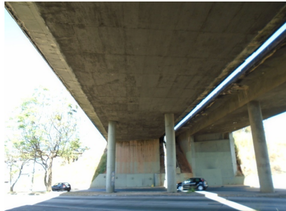
Figura 3 - Vista inferior dos viadutos da Av. Antônio Carlos.
