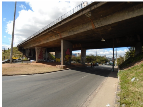
Figura 5 - Vista inferior dos viadutos da Av. D. Pedro II.
