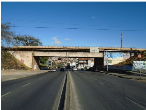
Figura 6 - Vista geral dos viadutos da Av. Ivaí.
