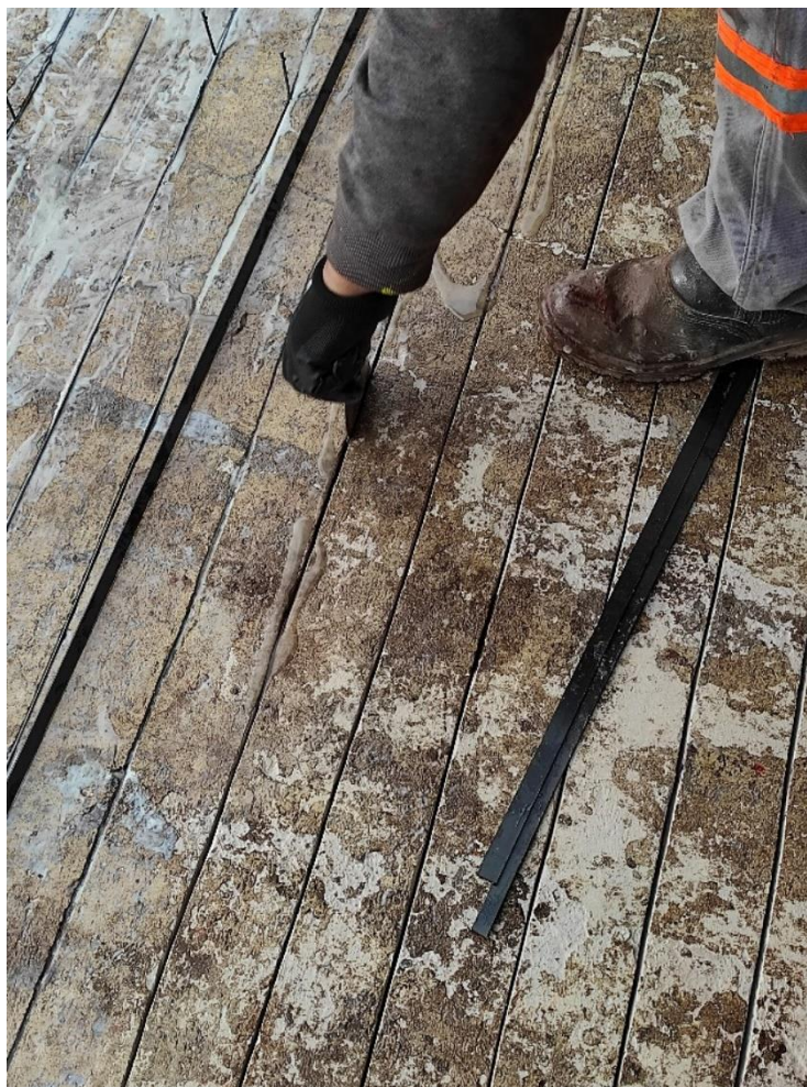
Figura 11 – Foto mostrando colocação de fibra inserida.
