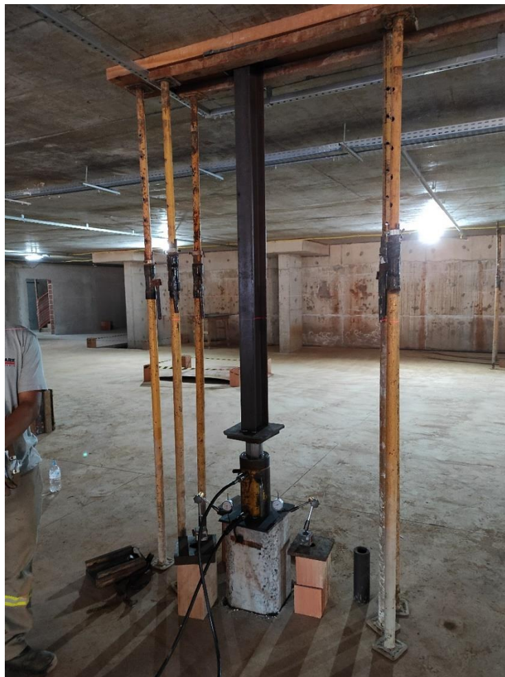
Figura 6 – Foto mostrando a cravação de uma estaca.
