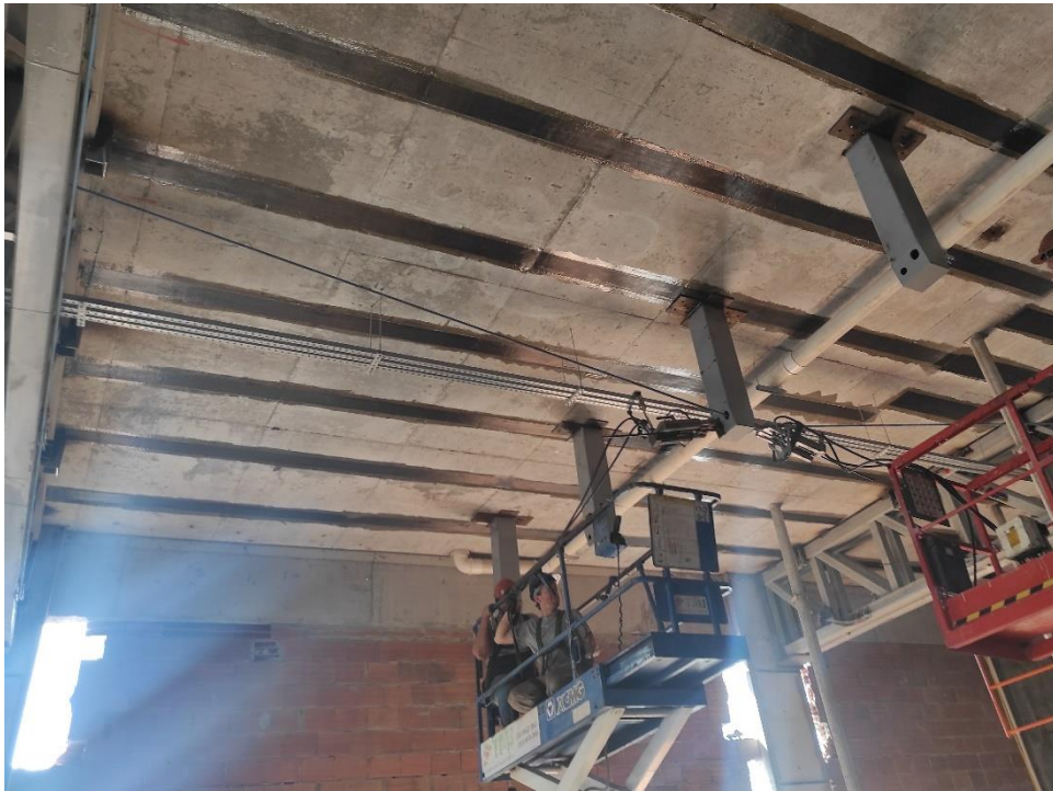
Figura 9 – Foto mostrando a aplicação da protensão externa com um desviador.
