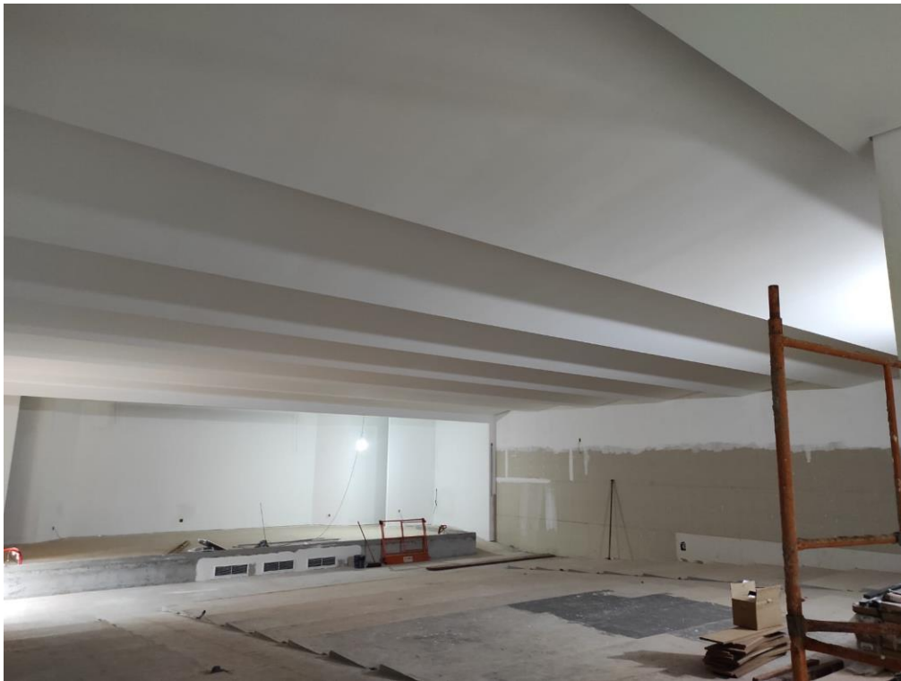
Figura 16 – Foto do teto do auditório depois do forro falso
