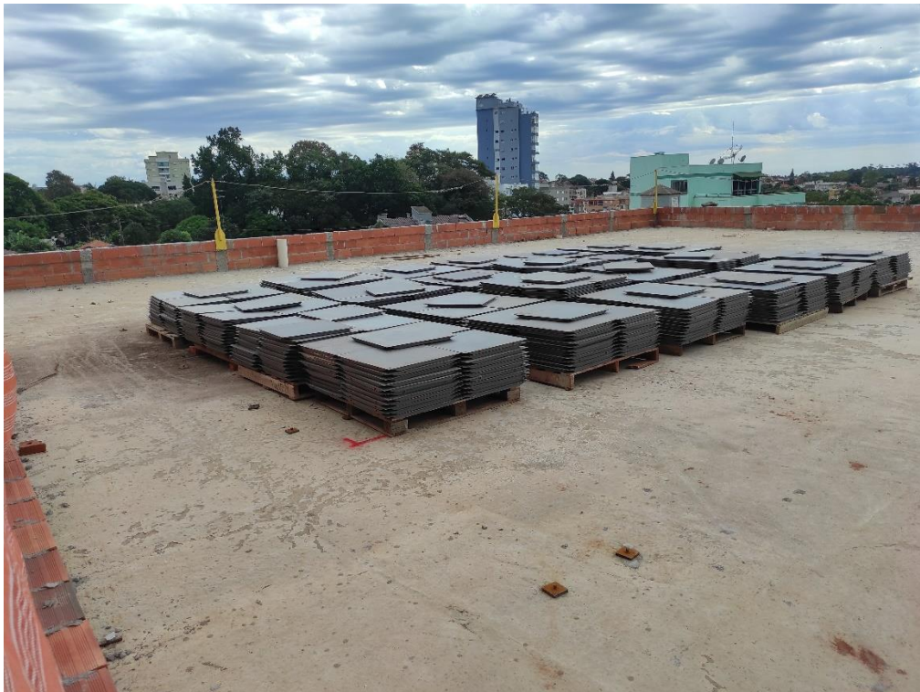
Figura 12 – Foto do carregamento de uma laje.
