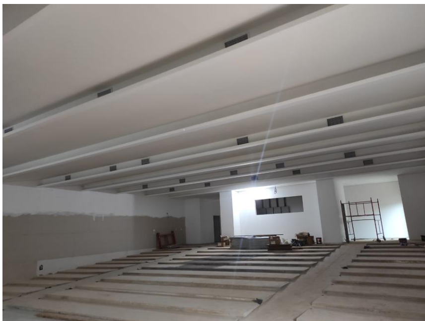
Figura 15 – Foto do teto do auditório depois do forro falso
