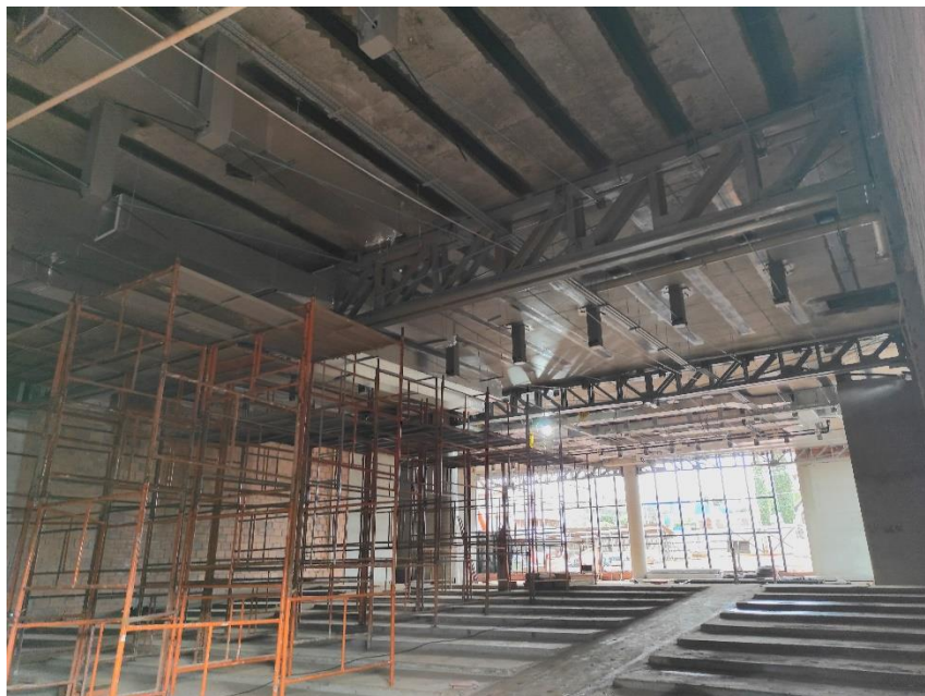
Figura 14 – Foto do teto do auditório antes do forro falso.
