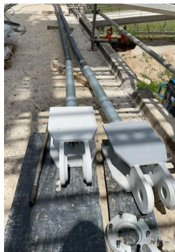
Figura 21 – Estais montados para instalação na passarela Santista
