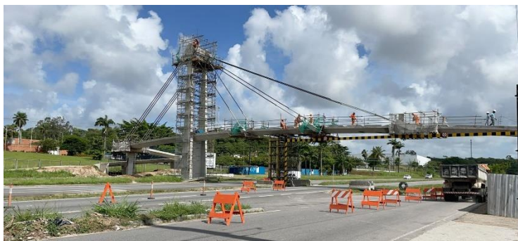
Figura 25 – Vista longitudinal da instalação dos estais da passarela Santista
