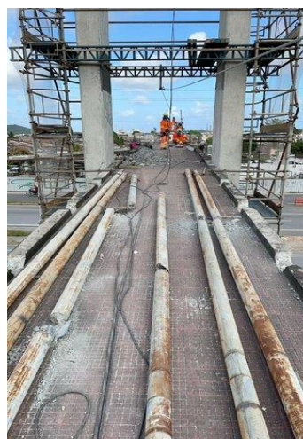
Figura 29 – Estais removidos da passarela Santista
