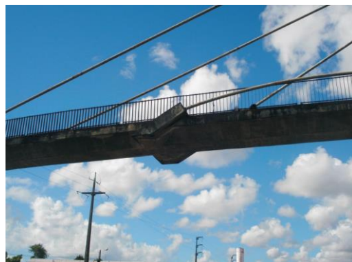
Figura 5 – Vista inferior do tabuleiro da Passarela Santista
