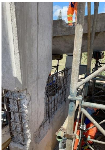
Figura 20 – Recuperação de um dos pilares da rampa de acesso
