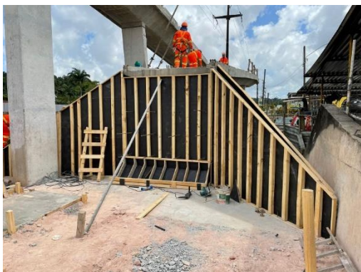
Figura 24 – Montagem da fôrma do encontro da rampa de acesso
