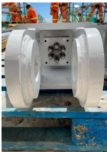
Figura 22 – Detalhe da nova ancoragem dos estais
