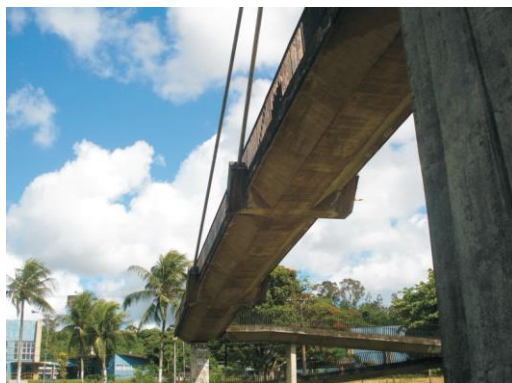
Figura 7 – Vista inferior do tabuleiro da Passarela Leon Heimer
