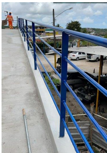
Figura 26 – Vista do guarda-corpo implantado
