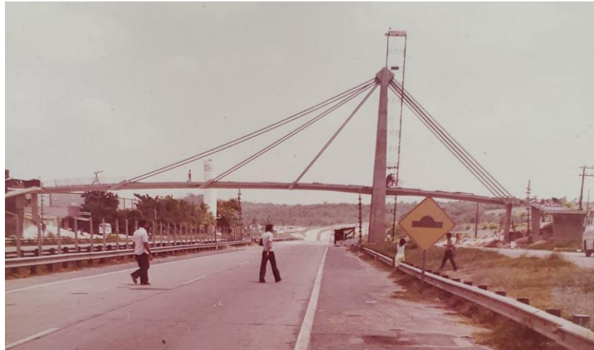
Figura 2 – Vista longitudinal à época da construção (Passarela Santista)
