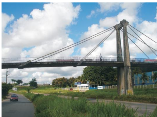
Figura 6 – Vista geral da Passarela Leon Heimer
