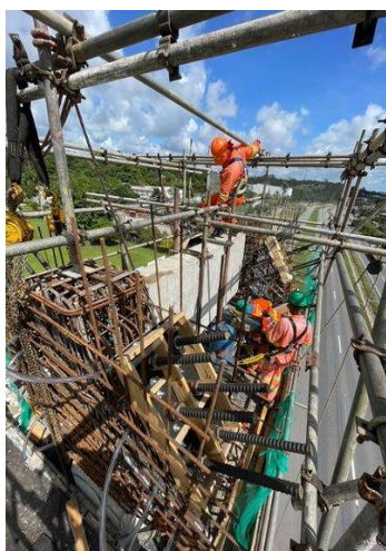
Figura 28 – Detalhe da armadura de reforço do mastro
