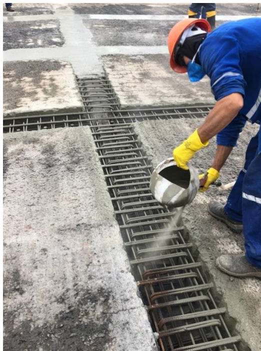
Figura 7 – pulverização da pintura de cristalização na junta fria como ponte de aderência (fonte ANTW Engenharia).
