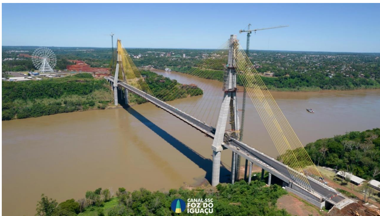
Figura 1 – Foto panorâmica da ponte Brasil – Paraguai (Fonte ANTW Engenharia).
