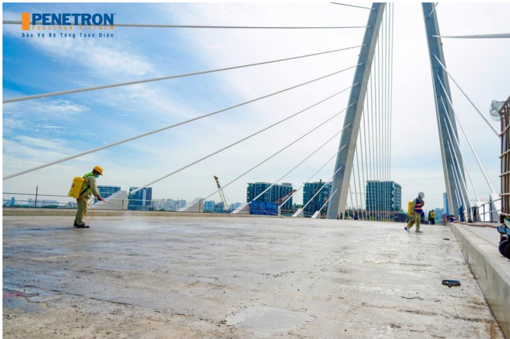
Figura 10 – exemplo de aplicação por pulverização de selador à base de silicato modificado (fonte Penetron Intl).
