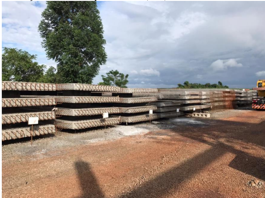
Figura 5 – lajes pré-moldadas no canteiro (fonte ANTW Engenharia).
