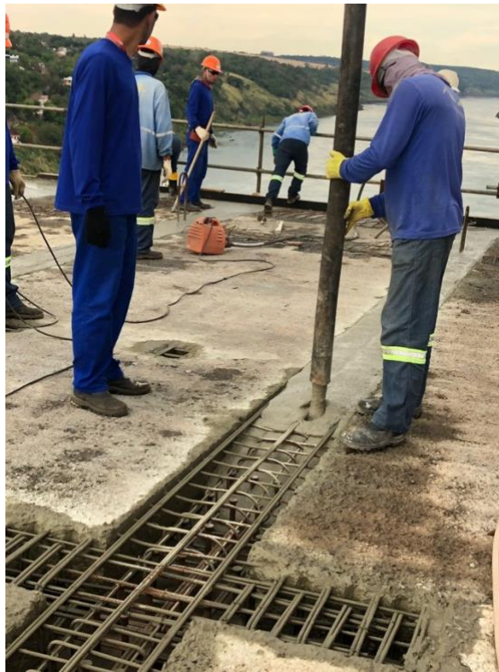
Figura 8 – grauteamento com concreto com aditivo cristalizante (fonte ANTW Engenharia).
