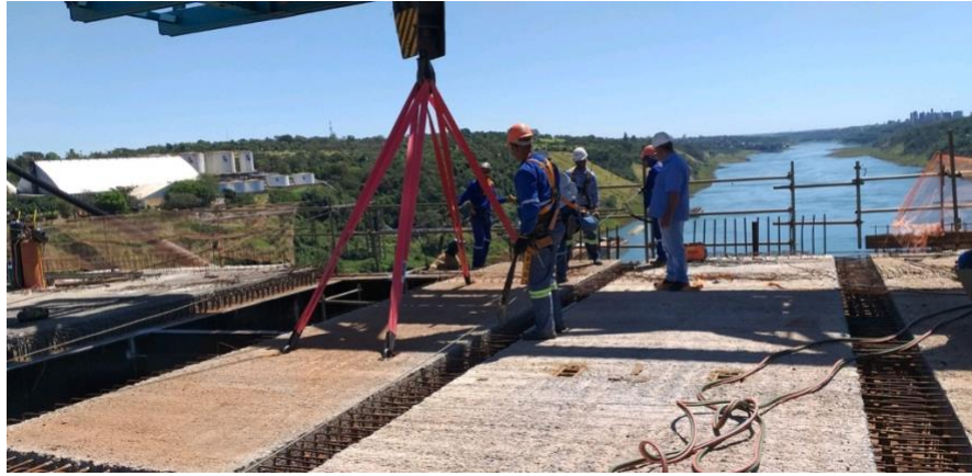
Figura 6 – lajes pré-moldadas empurradas no tabuleiro (fonte ANTW Engenharia).
