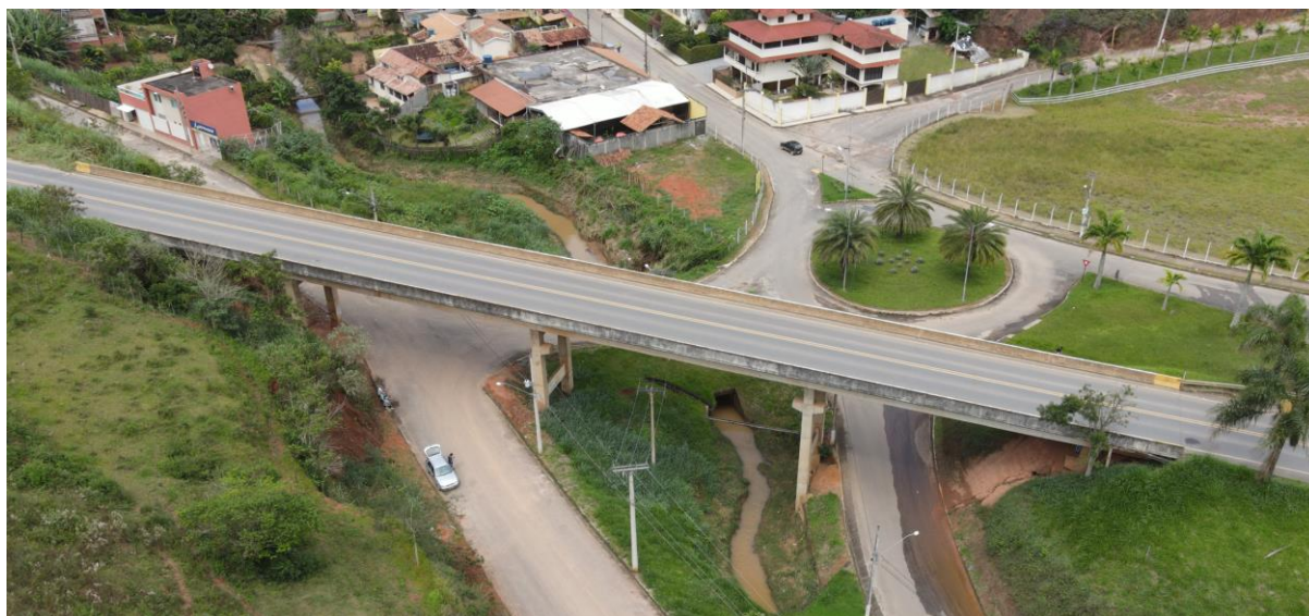
Figura 2 – Ponte da cidade de Coimbra (MG) – vista aérea.
