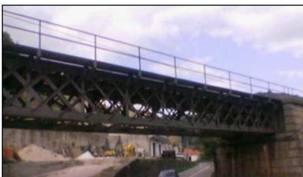
Figura 6 – Treliça com estrado superior. Fonte: Poças (2009).
