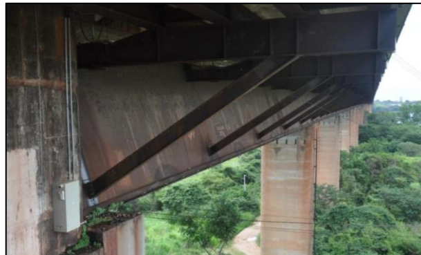
Figura 3 – Viga caixão metálica. Fonte: Próprio autor.
