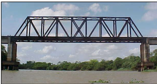
Figura 4 – Treliça com estrado inferior e contraventamento superior. Fonte: Montoya et al. (2010).
