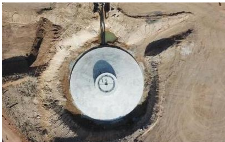
Figura 03 – Fundação de aerogerador após a etapa de concretagem
