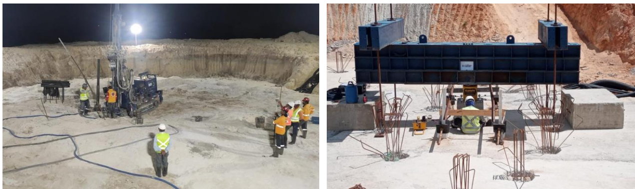
Figura 05 e 06 – Execução de estaca tipo raiz e prova de carga em estaca
