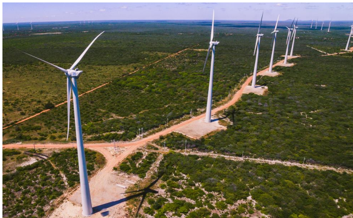
Figura 1: Parque eólico em operação no Brasil.
