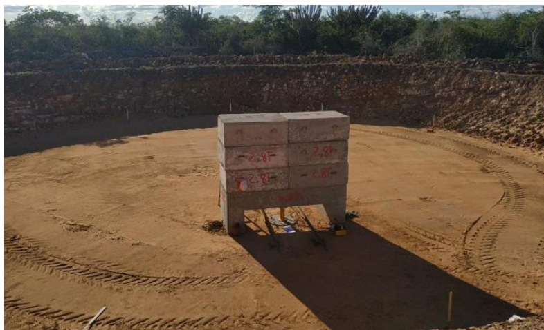
Figura 04 – Estrutura da prova de carga em placa.
