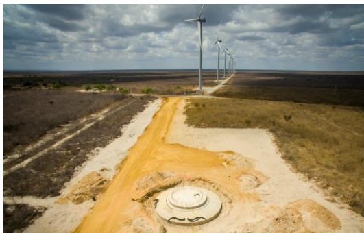
Figura 03 – Ilustração de uma fundação de aerogerador e ao fundo um empreendimento eólico.
