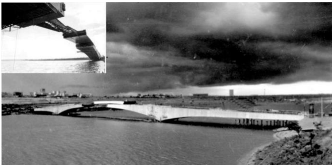
Figura 6 – Montagem mostrando a implantação do tabuleiro metálico de 58 m, no vão central (Arquivo Público do Distrito Federal, 1976).
