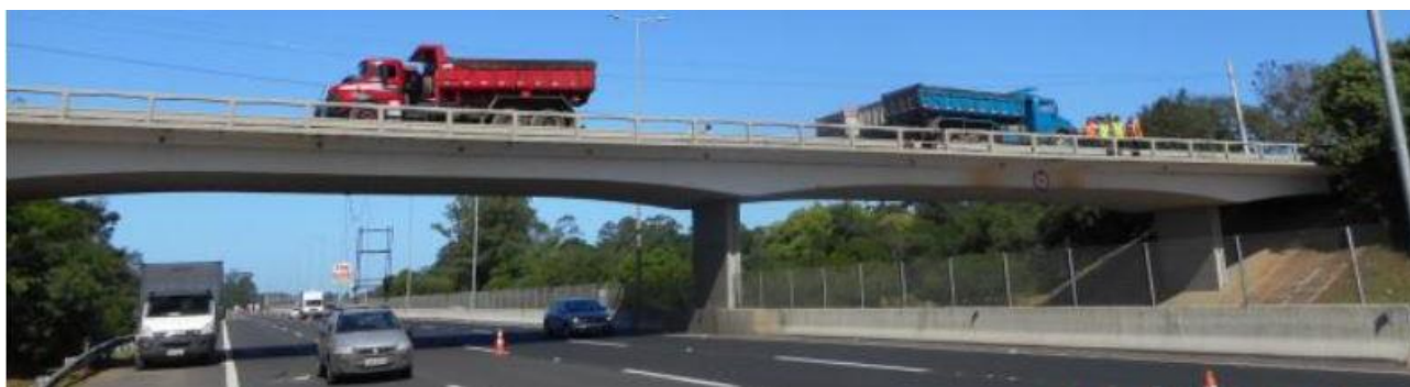
Figura 5. Teste de Carga Estático sendo realizado sobre o Viaduto
