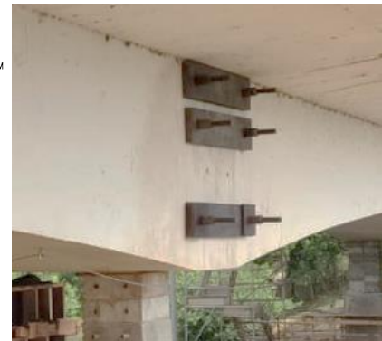
Figura 9. Reforço Localizado das Transversinas usando Barras de Protensão
