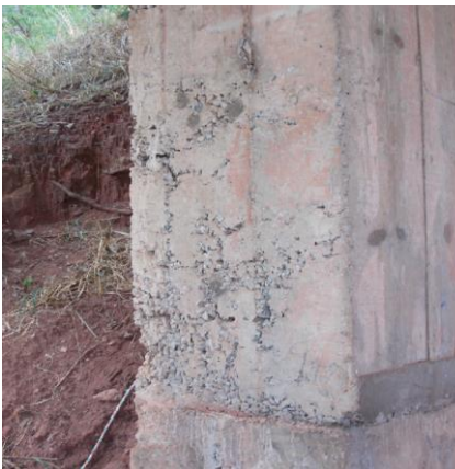
Figura 7 – Nicho de concretagem (SGO, 2020).
