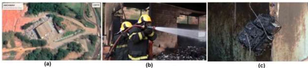
Figura 8: (a) vista superior do local, (b) equipe de bombeiros apagando as chamas dos galpões, ao fundo da imagem pode-se observar a deformação da estrutura do galpão causada pela exposição das altas temperaturas provocadas pelas chamas e (c) disjuntor deteriorado após ser consumido pelas chamas. - Fonte: TV Leste, 2017.
