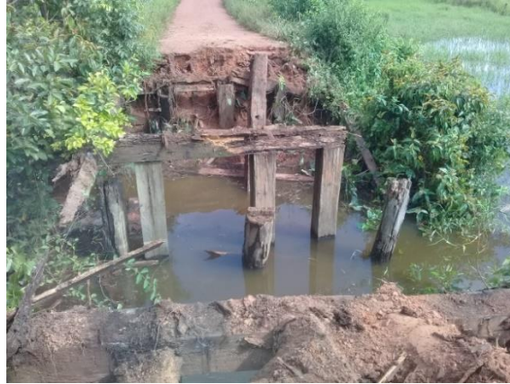
Figura 9: Estado de conservação da ponte C8- Ponte I
