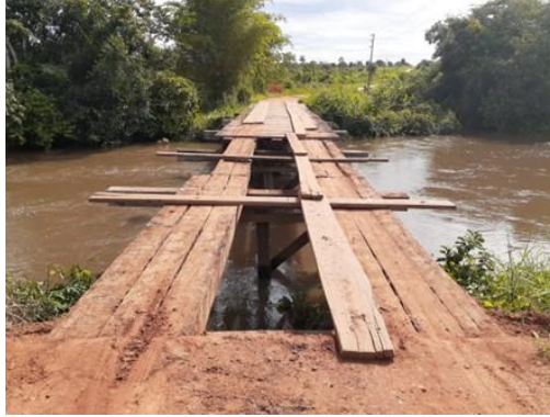
Figura1: Estado de conservação da ponte C4 – Ponte A
