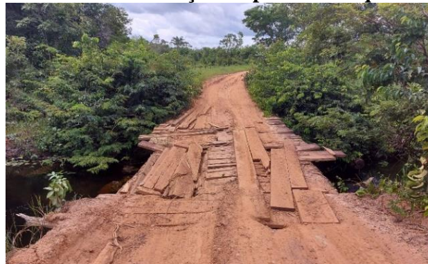
Figura 10: Estado de conservação da ponte Branquelandia - Ponte J
