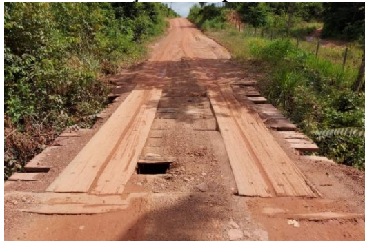
Figura 7: Estado de conservação da 3° ponte da PA151km 26- Ponte G
