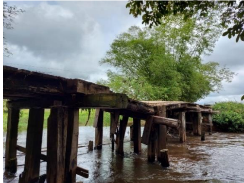
Figura 3: Estado de conservação da 2ª ponte C8- Ponte C
