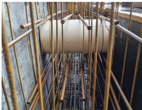
Figura 3 – Posicionamento das armaduras de reforço junto a abertura (COGO, 2022)
