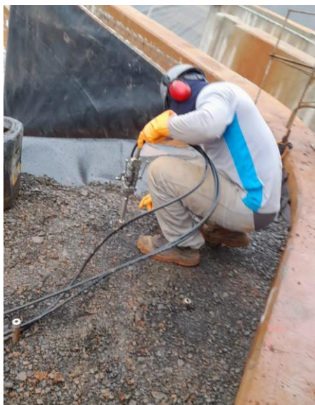
Figura 16- Injeção de poliuretano (Fonte: acervo digital da Gmaia)
