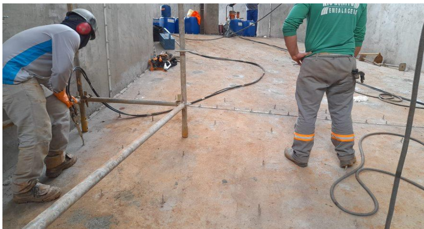
Figura 8 - Injeção de poliuretano (Fonte: acervo digital da Gmaia)
