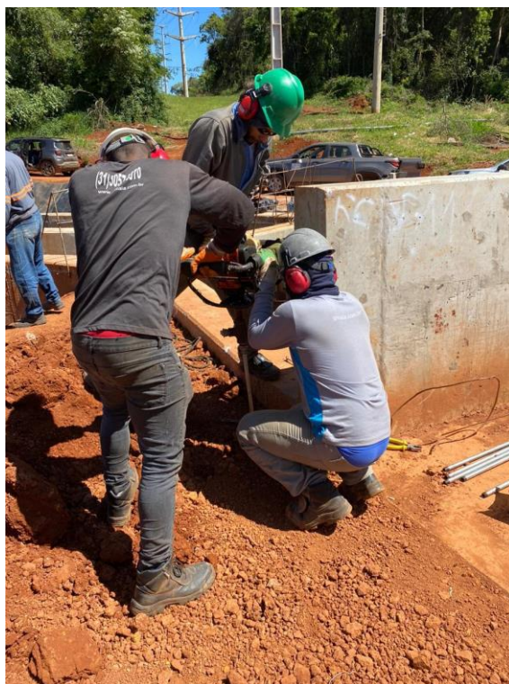
Figura 12 - Perfuração em terreno (Fonte: acervo digital da Gmaia)
