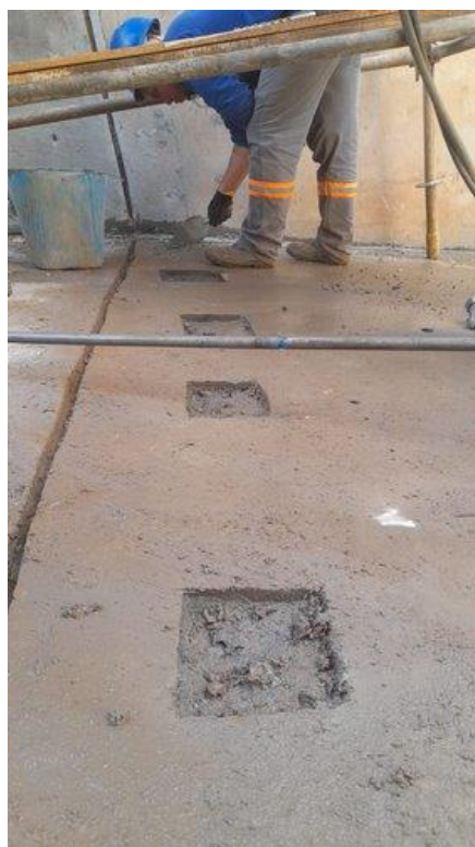
Figura 9 – Quebra de furos (Fonte: acervo digital da Gmaia)
