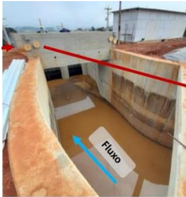
Figura 3 - Estrutura antes do início dos serviços (Fonte: acervo digital da Gmaia)
