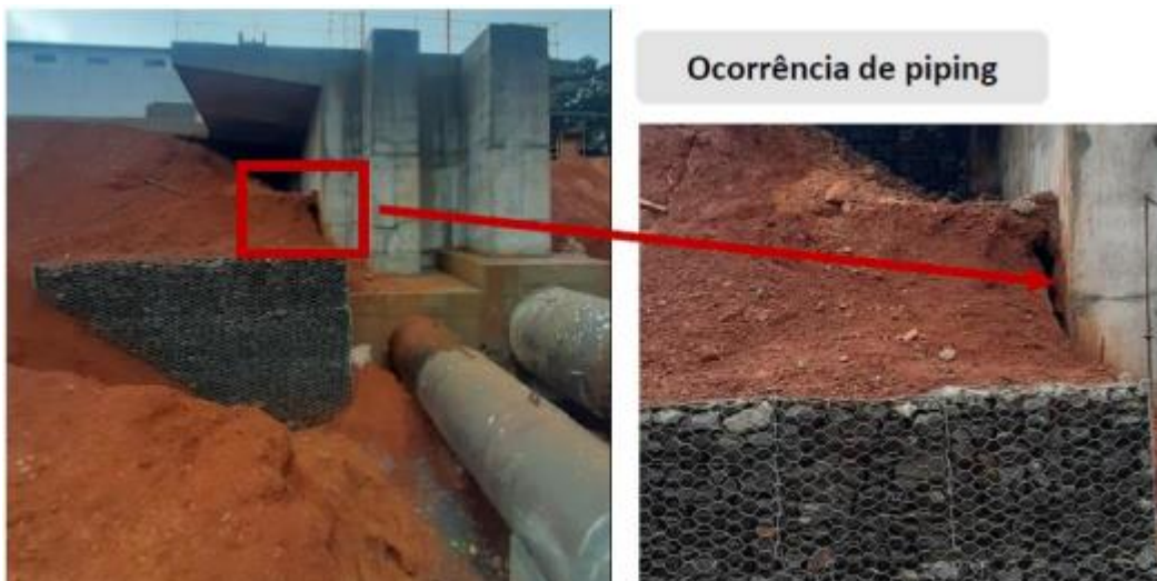
Figura 4 - Estrutura antes do início dos serviços (Fonte: acervo digital da Gmaia)
