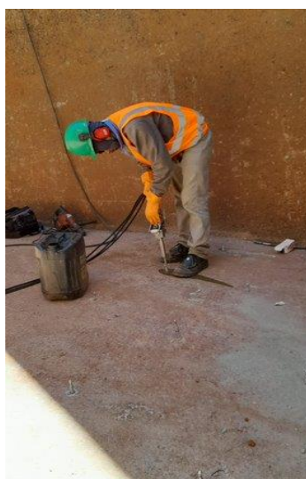
Figura 7 - Injeção de poliuretano (Fonte: acervo digital da Gmaia)
