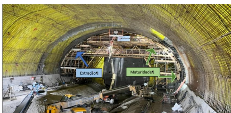
Figura 5 – Indica os locais de instalação dos sensores do Datalogger e das extrações.
