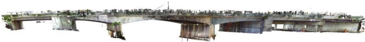
**Figura 1 – Vista tridimensional da nuvem de pontos da ponte Eusébio Matoso (NETO ET AL., 2021)**
