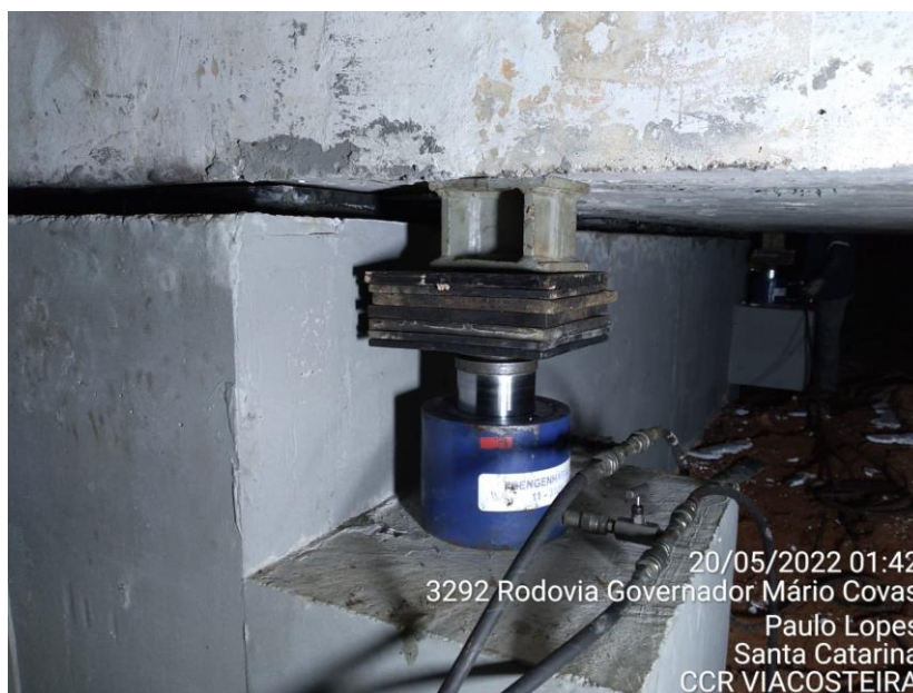
Figura 22 – Posicionamento dos calços nos pontos de macaqueamento
