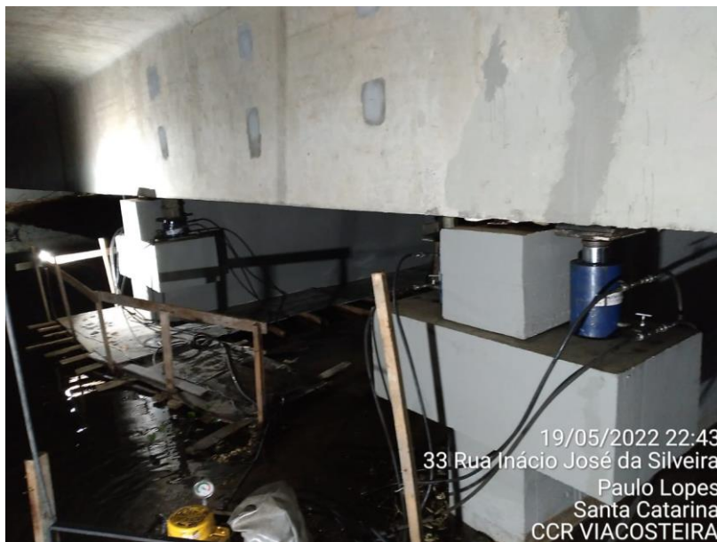
Figura 21 – Operação de deslocamento da superestrutura por meio de macacos hidráulicos
