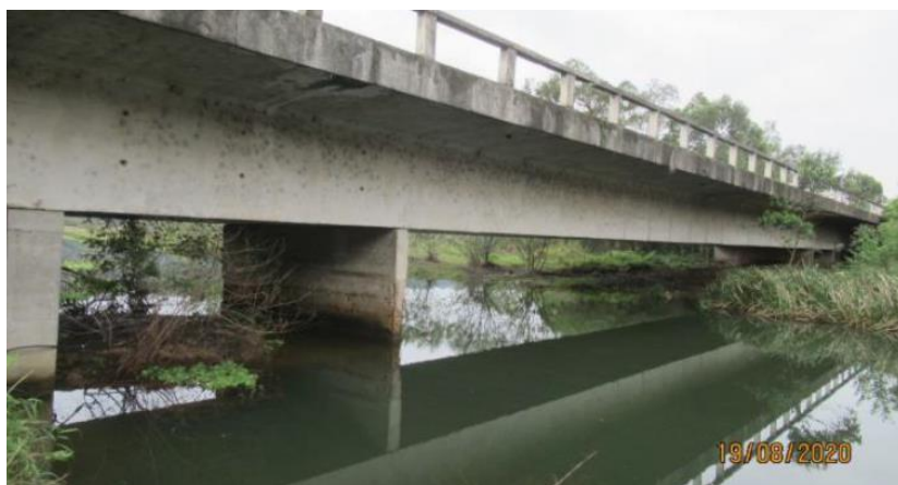
Figura 1 – Foto da elevação da ponte sobre o rio Paulo Lopes
