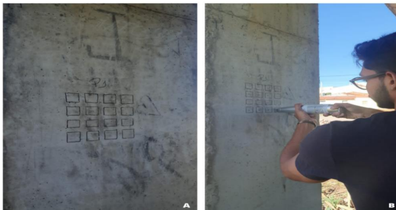
Figura 2- (A): Área de ensaio e pontos de impacto. (B): Aplicação de esclerômetro no pilar.
