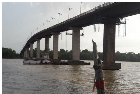
Figura 2– Vista da margem direita da Ponte Acará, LSE, 04/10/19.
