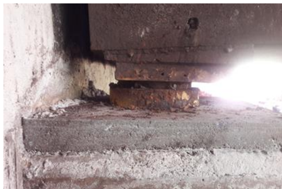
Figura 3 – Detalhe transversal do aparelho de apoio multidirecional 01 do E1, 10/10/19.
