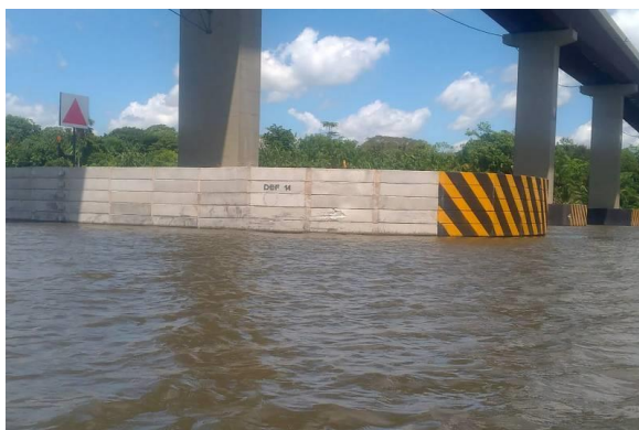
Figura 4 – Vista lateral defesa flutuante Ponte do Acará.
