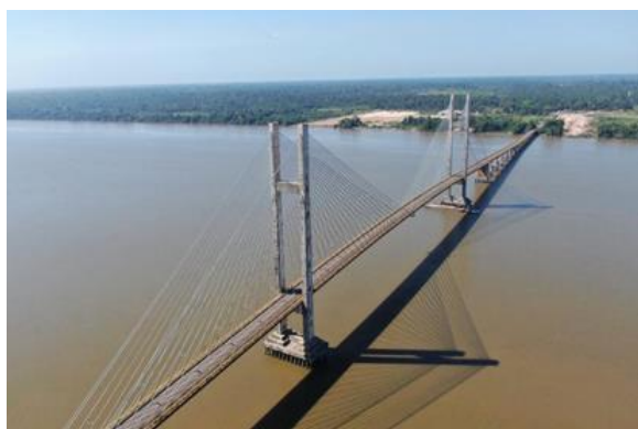
Figura 1 - Vista geral da ponte com mastro construído com 2 pilares de sustentação dos cabos-estais, foto com drone, LSE
