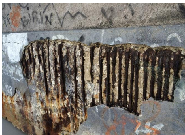
Figura 1. Corrosão em armaduras de estruturas de concreto devido à presença de cloretos.
