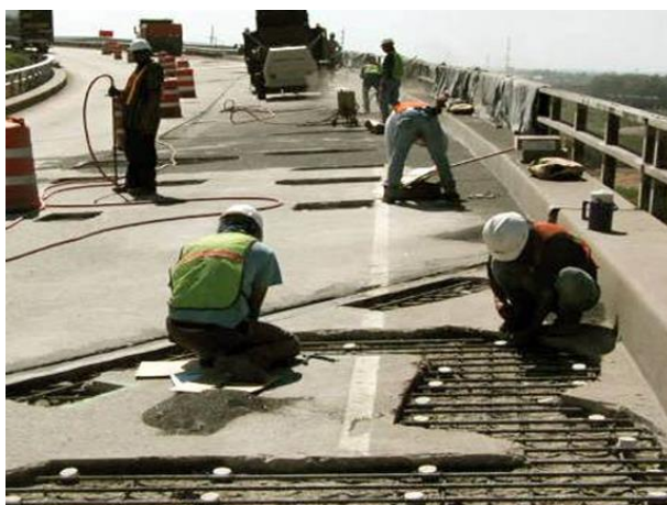
Figura 3. Instalação de anodos galvânicos Galvashield XP durante os serviços de reabilitação/recuperação de uma ponte.
