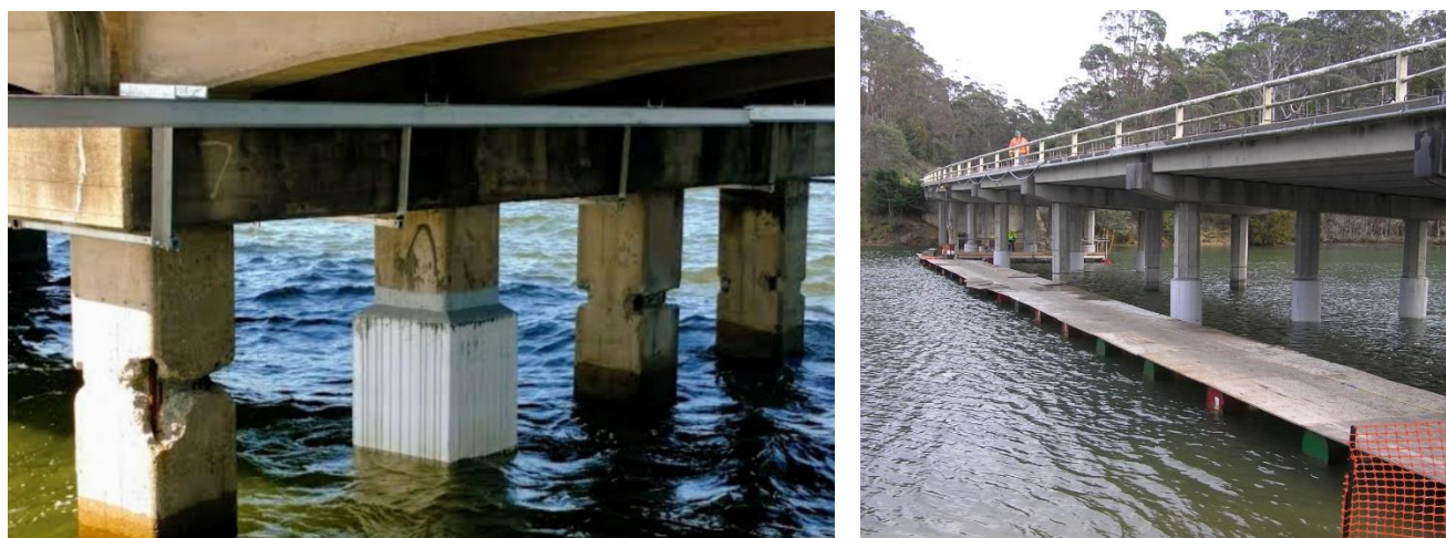
Figura 10 Instalação do sistema Galvashield Jacket para a proteção de estacas de concreto na zona de variação de marés.
