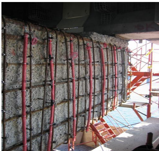
Figura 4. Instalação de anodos galvânicos Galvashield DAS (peças vermelhas e verdes) durante os serviços de reabilitação de uma estrutura de concreto no mar. A instalação dos anodos durante os serviços de reabilitação é a única maneira de garantir proteção integral das armaduras a longo prazo, qualquer que seja o teor de cloretos e de umidade presentes.
