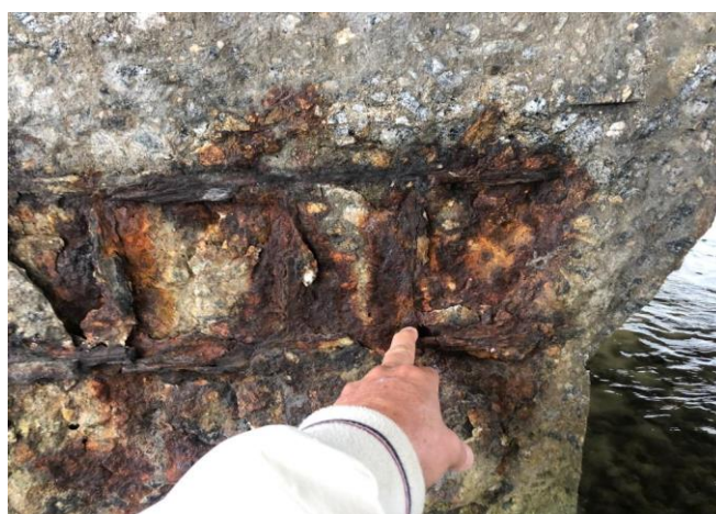
Figura 1. Corrosão em armaduras de estruturas de concreto devido à presença de cloretos.
