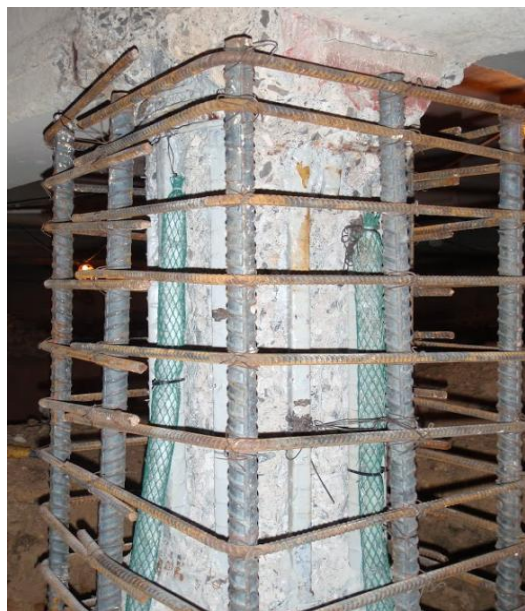
Figura 5. Outro exemplo de instalação dos anodos galvânicos Galvashield DAS (peças verdes), agora nos serviços de reabilitação e reforço dos pilares de um edifício residencial nas proximidades do mar.
