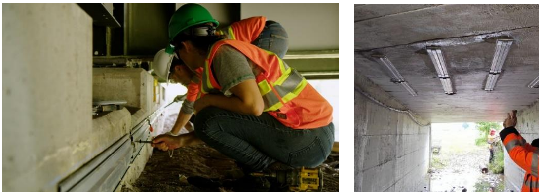
Figura 9. Anodos galvânicos Galvashield SM-DAS instalados sobre a superfície e sem a necessidade de quebrar ou furar o concreto. A instalação é feita nos locais de corrosão ativa, identificados através das medições dos potenciais das armaduras em relação ao concreto ou nos locais onde o concreto foi recuperado.
