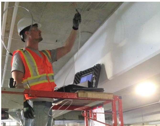
Figura 7. Medições dos potenciais das armaduras em relação ao concreto, com o auxílio de um voltímetro de alta impedância e um eletrodo de referência de Cu/CuSO 4 . De acordo com os resultados consegue-se mapear as regiões de corrosão ativa e definir os locais para a instalação dos anodos galvânicos Galvashield CC, sem a necessidade de quebrar o concreto e expor as ferragens.
