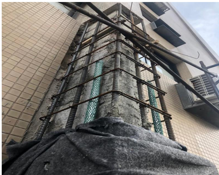
Figura 5. Outro exemplo de instalação dos anodos galvânicos Galvashield DAS (peças verdes), agora nos serviços de reabilitação e reforço dos pilares de um edifício residencial nas proximidades do mar.
