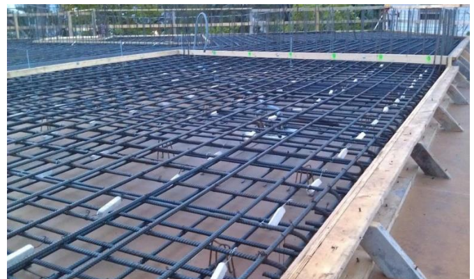
Fig. 2 – Instalação de anodos galvânicos de proteção catódica. Os anodos são simplesmente amarrados às armaduras durante os serviços de reabilitação de obras antigas ou de construção de uma obra nova.
