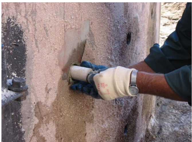
Figura 8. Instalação de anodos galvânicos Galvashield CC em pilar de viaduto e em coluna de um edifício residencial, nos locais onde as medições dos potenciais indicaram a presença de corrosão ativa.
