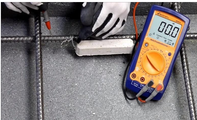
Fig. 2 – Instalação de anodos galvânicos de proteção catódica. Os anodos são simplesmente amarrados às armaduras durante os serviços de reabilitação de obras antigas ou de construção de uma obra nova.
