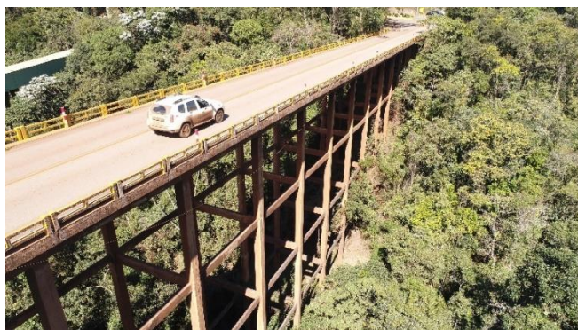
Figura 1 – Viaduto da Mutuquinha em sua condição original do tabuleiro.
