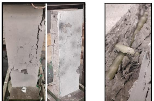
a) Ruptura em duas faces do pilar b) Ruptura da armadura transversal
