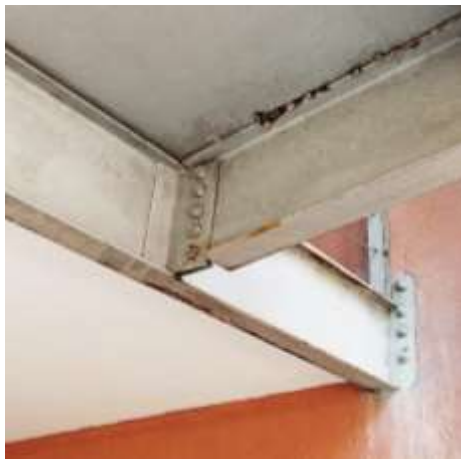
Figura 4 – Ligação LCSP.
