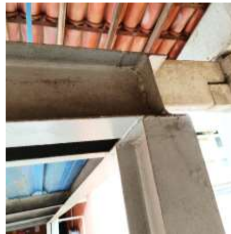
Figura 5 – Ligação soldada.
