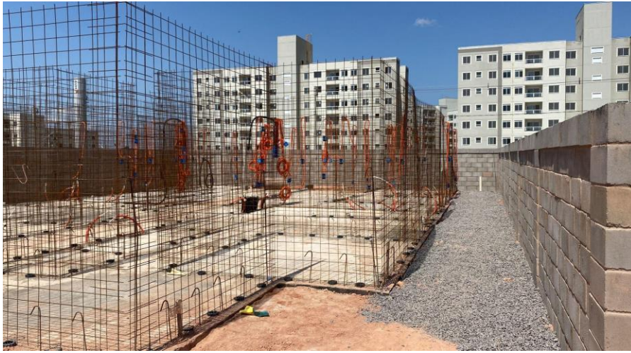
Figura 1 - Armação das paredes (Autor, 2025).
