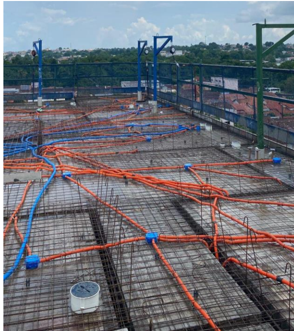
Figura 2 - Laje finalizada, apenas para o lançamento do concreto (Autor, 2025).
