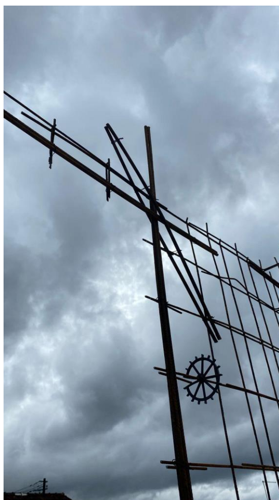
Figura 5: Detalhe superior dos reforços armados dos vãos de portas (Autor, 2025).
