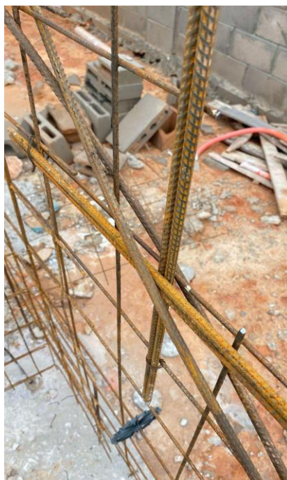
Figura 3: Reforço estrutural usando Aço CA50 Ø 8.0, em vãos de janela (Autor, 2025).
