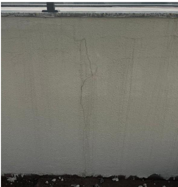
Figura 13 – Evolução de trinca na alvenaria do deck da piscina em 2 meses (Autor, 2025).
