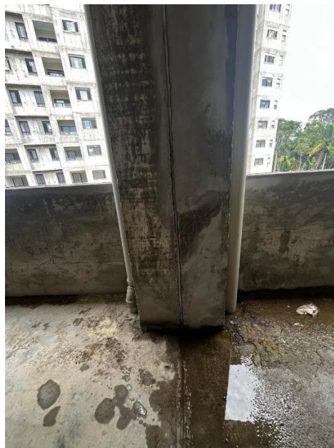
Figura 6 – Junta de dilatação visão interna (Autor, 2025).
