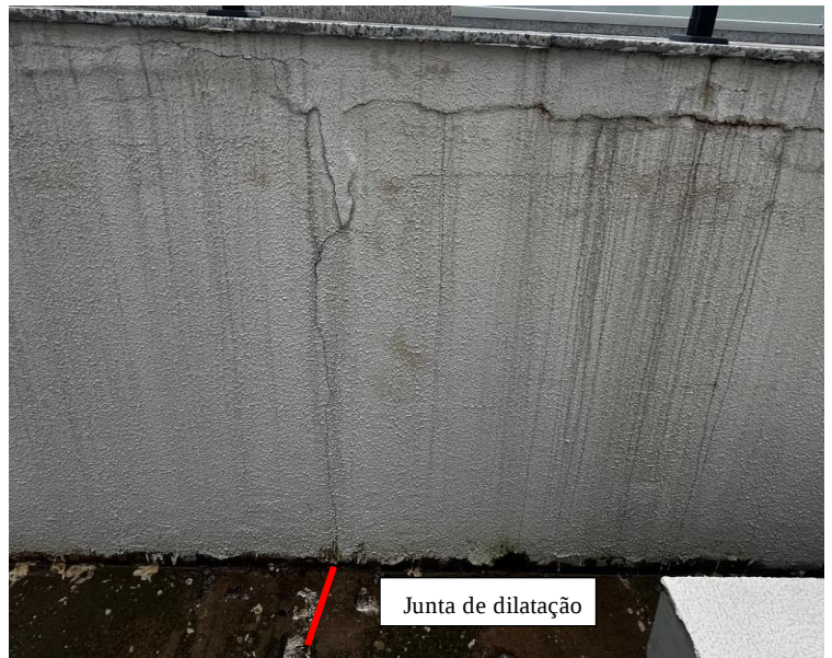
Figura 13 – Evolução de trinca na alvenaria do deck da piscina em 2 meses (Autor, 2025).
