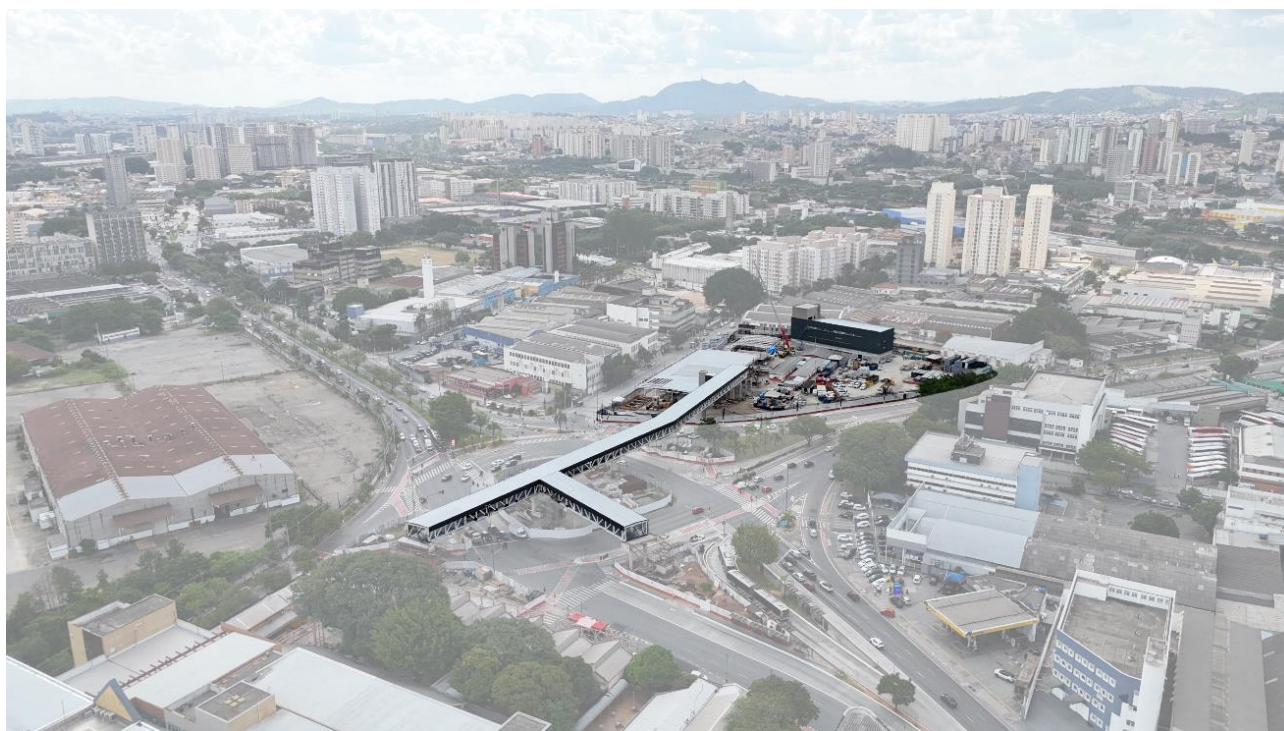
Figura 7 - Passarela e cobertura metálica. Fonte: Elaborado pelo autor
