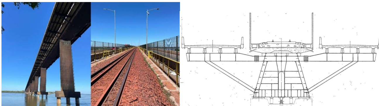
Figura 1 – Ponte sobre o rio Tocantins, Estrada de Ferro Carajás (EFC), Marabá, PA.
