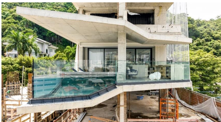
Figura 1 – Piscina privativa em balanço empreendimento Infinitá Treehouse.
