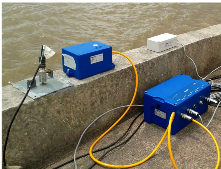
Figura 8 - Utilização de acelerômetro em uma ponte (DYNAMIS TECHNÉ, 2025).
