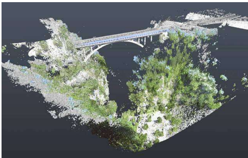
Figura 7 - Nuvem de pontos de viaduto gerado por drones (ALAURIA, 2023).
