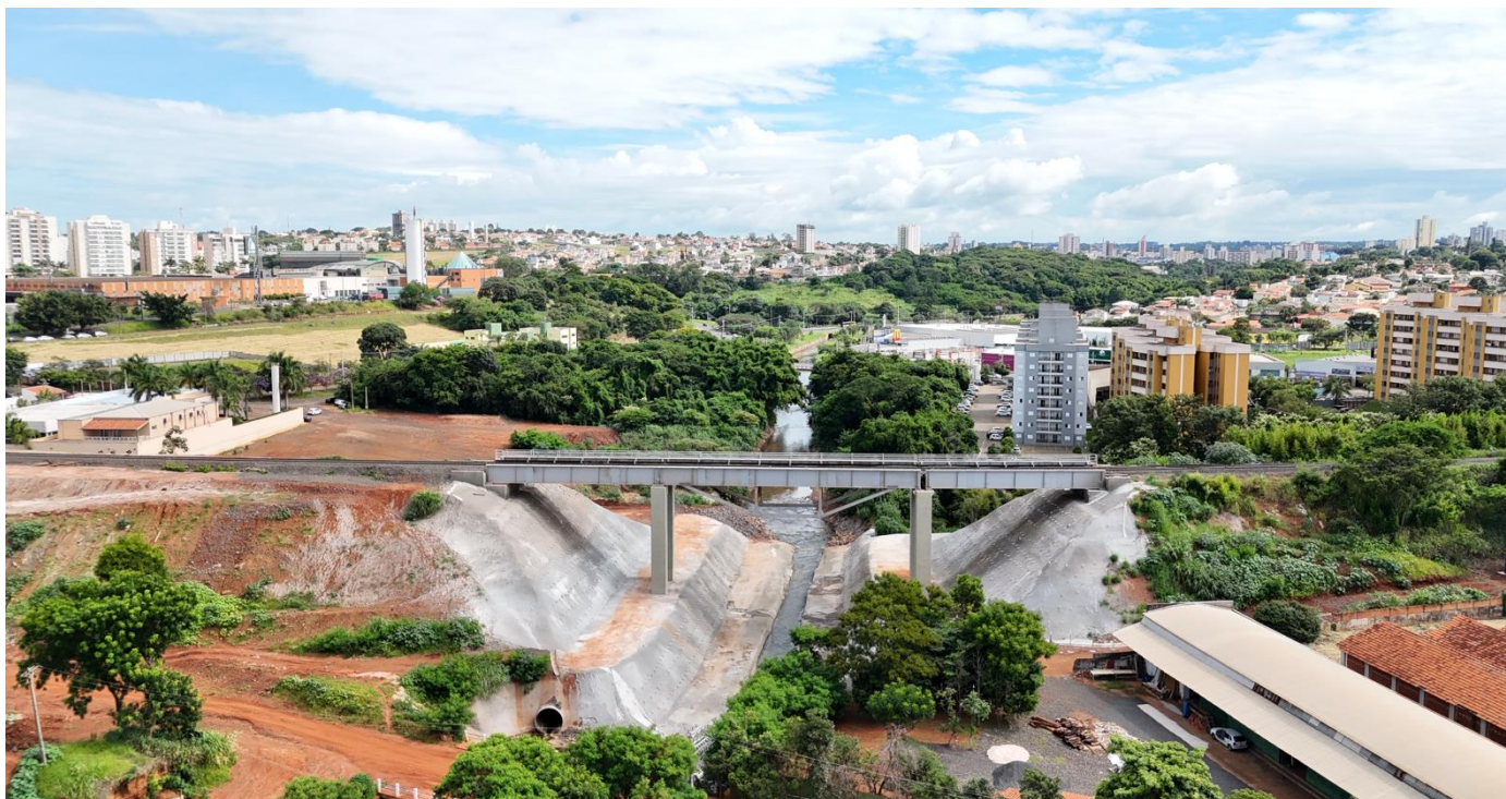
Figura 1 - Imagem aérea da Ponte Ferroviária sobre o córrego Monjolinho - São Carlos -SP
