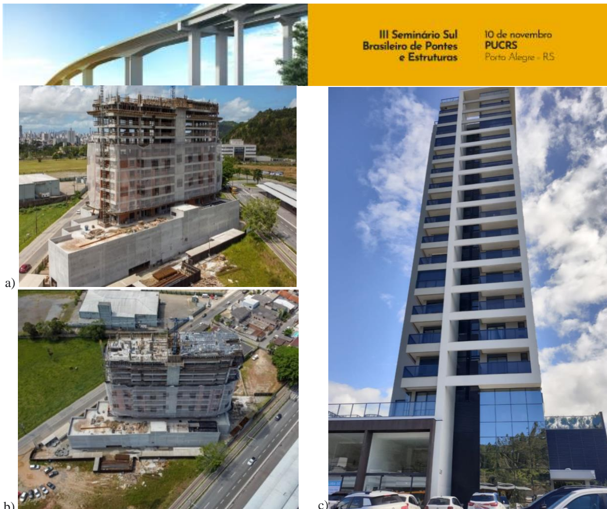
Figura 4 – a) Etapa de finalização da estrutura, b) vista superior da obra do edifício e c) edifício executado e em uso.
