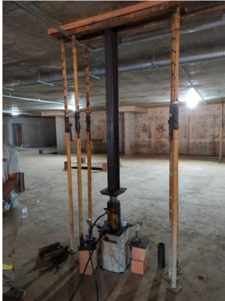
Figura 6 – Foto mostrando a cravação de uma estaca.
