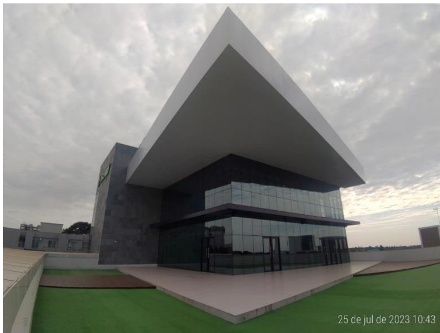
Figura 16 – Foto da marquise de aço depois de revestida
