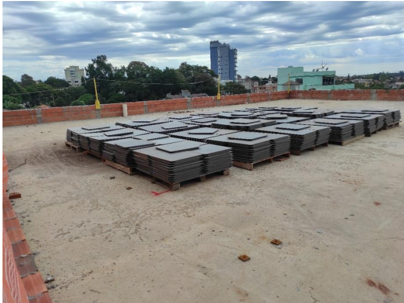
Figura 12 – Foto do carregamento de uma laje.
