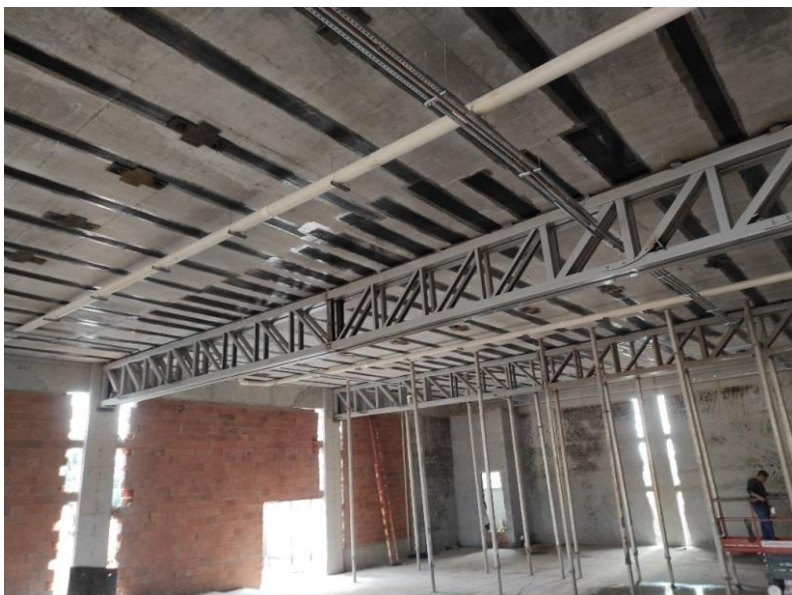
Figura 7 – Foto ambiental mostrando as treliças sobre o auditório.
