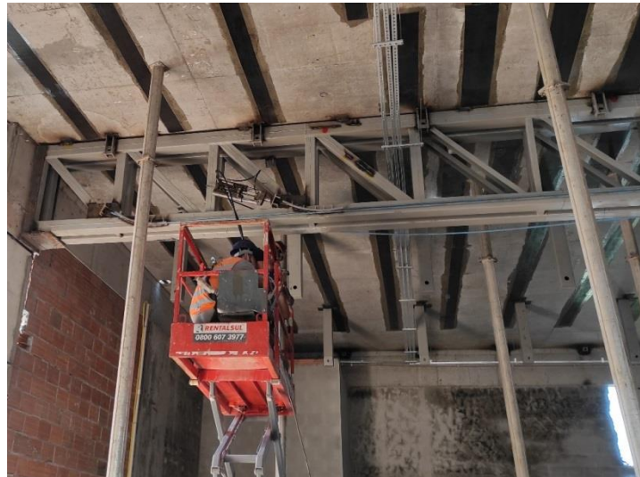
Figura 8 – Foto mostrando macaco aplicando protensão na treliça.
