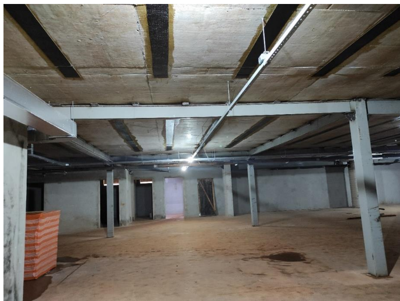
Figura 5 – Foto ambiental mostrando pilares e vigas metálicas do subsolo.
