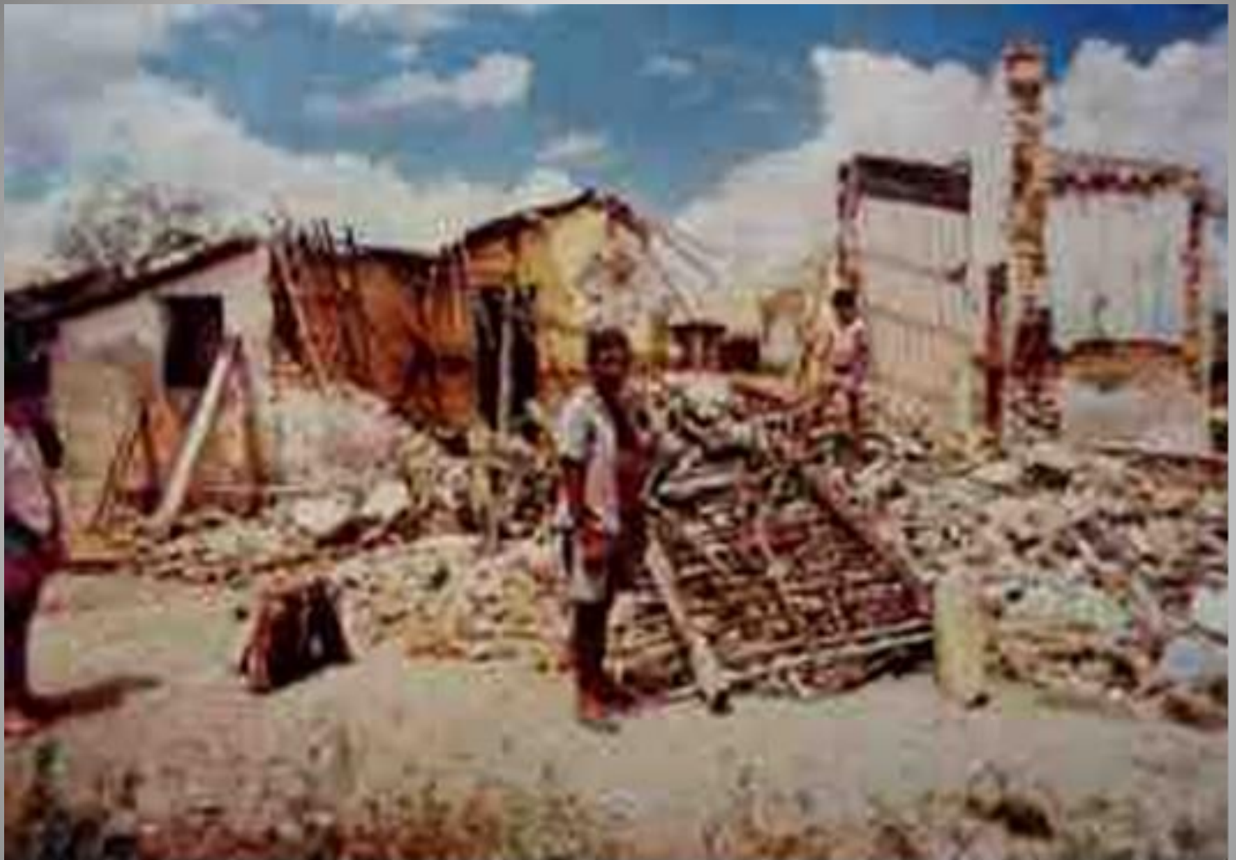
Efeitos do sismo na zona rural
