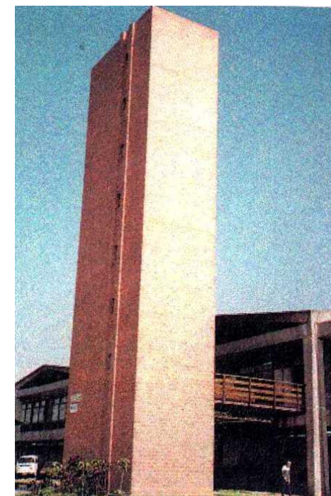
Torre do Laboratório de Hidráulica construída com blocos cerâmicos na EPUSP (parte do programa)
