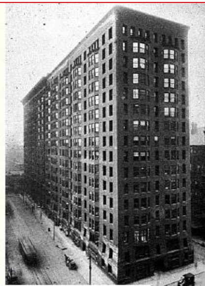
Parte norte Alvenaria estrutural
