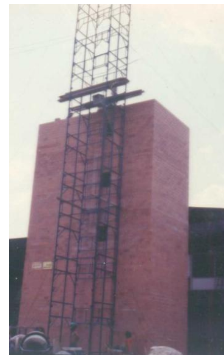
Torre do Laboratório de Hidráulica construída com blocos cerâmicos na EPUSP (parte do programa)
