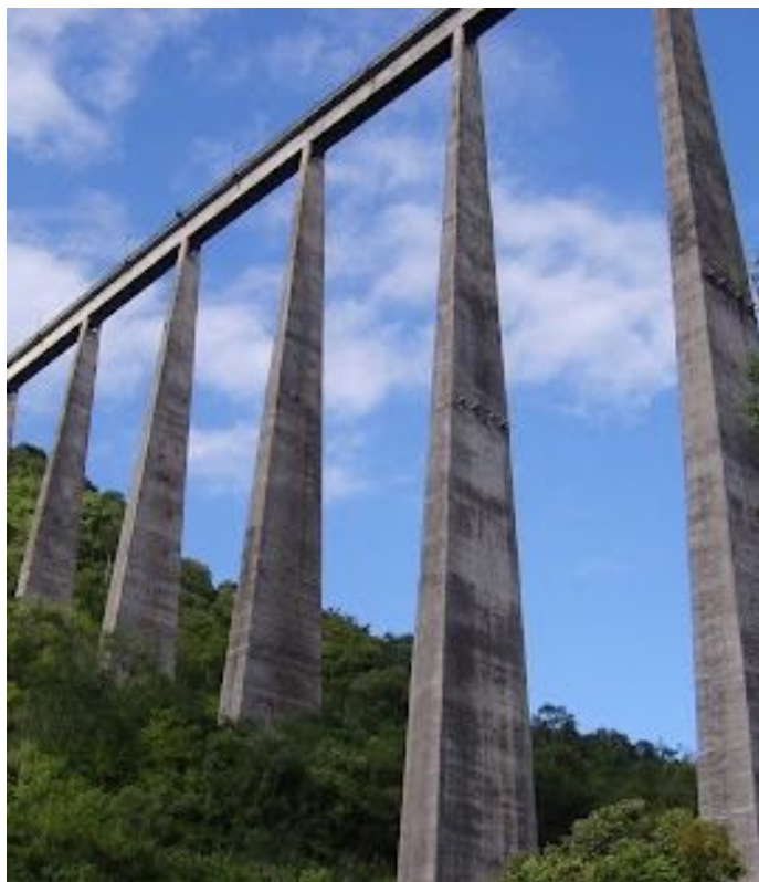
Viaduto 13 – h = 143 m Fonte: Wikipidea
