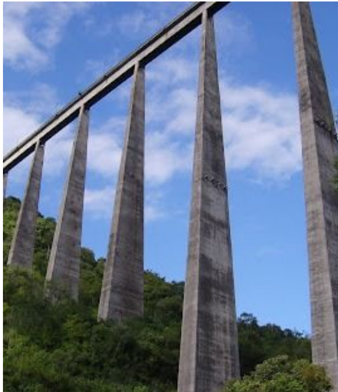
Viaduto 13 – h = 143 m Fonte: Wikipidea
